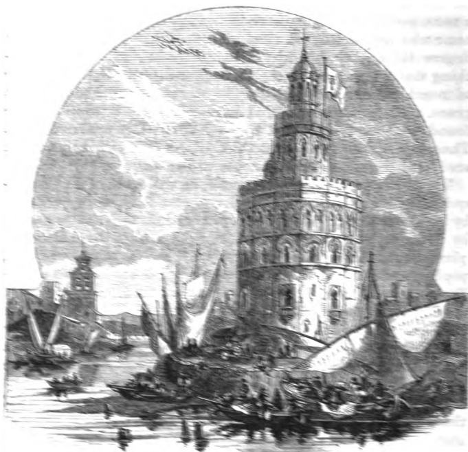
THE TOWER DEL ORO.
